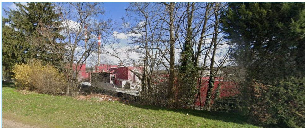
Vue sur le site depuis la rue des Rue des Anciens Bassins, à l'arrière des moyennes surfaces commerciales LIDL et GAMMVERT
