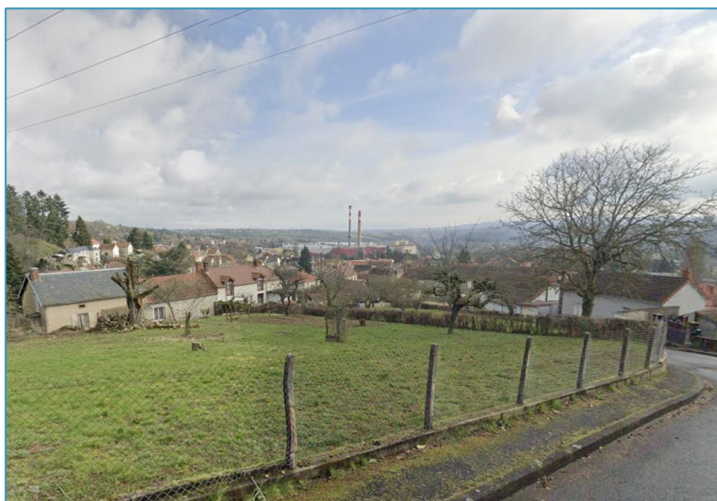
Vue sur le site ROCKWOOL depuis la Rue de Chez Ponet, au sein d'un secteur résidentiel au Nord-Ouest de la ville
