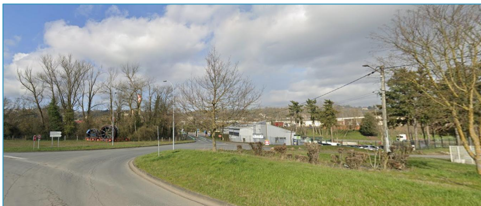
Vue sur le site depuis l'entrée livraisons/visiteurs, au Sud-Est du site de ROCKWOOL
