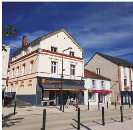
Exemples de ravalements de façade réalisés pendant l'OPAH 2016-2022, rue Jean Jaurès, Saint-Eloy-les-Mines
